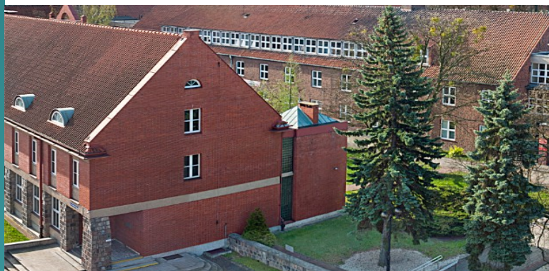
Projekt „Innowacje społeczne” zakłada remont budynku
